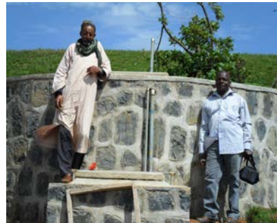
Edwin Visi, nuestro ingeniero consultor y un aldeano cerca de un tanque de almacenamiento terminado.
