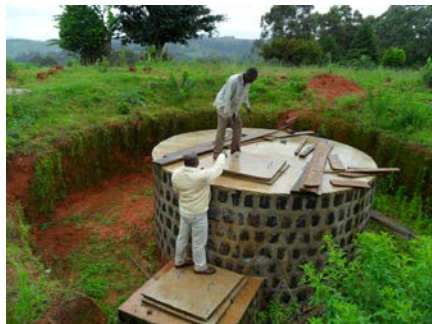
Edwin Visi, nuestro ingeniero consultor trabajando con un aldeano en el tanque de almacenamiento.
